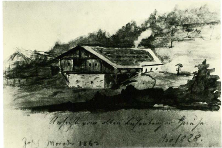
Ansicht vom alten Bauernhaus Lusenberg im Jahre 1828, vor der Erbauung des neuen herrschaftlichen Hauses; nach einer Bleistiftskizze des Josef Moroder-Lusenberg 1863.
